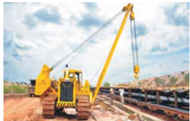
BP100 TON – PIPE LAYER
